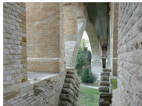
圖 8.18 阿道夫橋 (Pont Adolphe)
